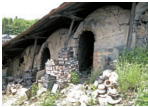
△山の斜面を利用して階段状に築かれた登り窯。中はいくつかの部屋に分かれていて、熱が上に行くのを利用して大量の品を一度に焼き上げる。
