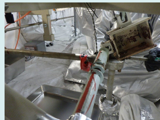
パイプカッターによる切断
