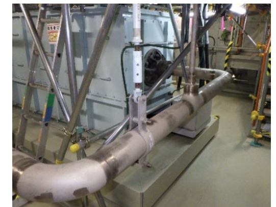
予熱・保温設備 (解体後)
