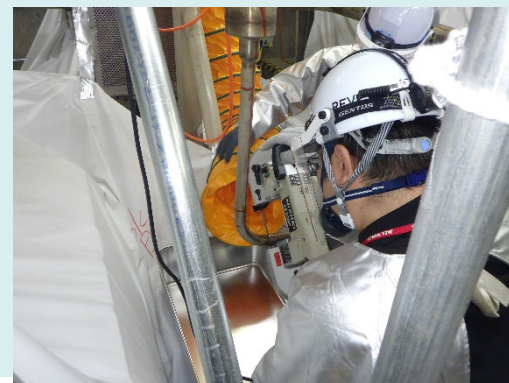
バンドソーによる切断
