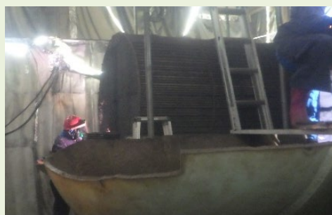
解体撤去作業中
