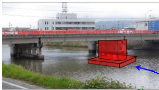
敦賀市松原橋 補強工事場所 (2基の橋脚のうち1基に使用)
