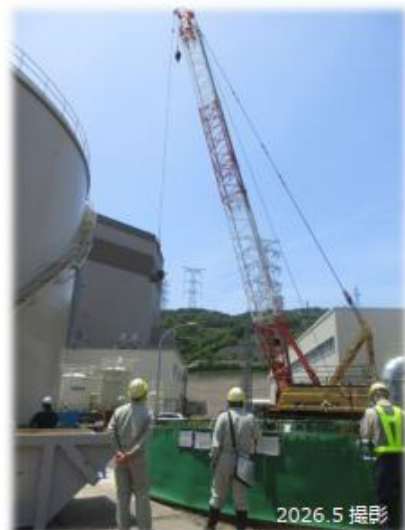
調査坑の掘削に必要な資機材の搬出入および土砂を搬出するための大型クレーン
