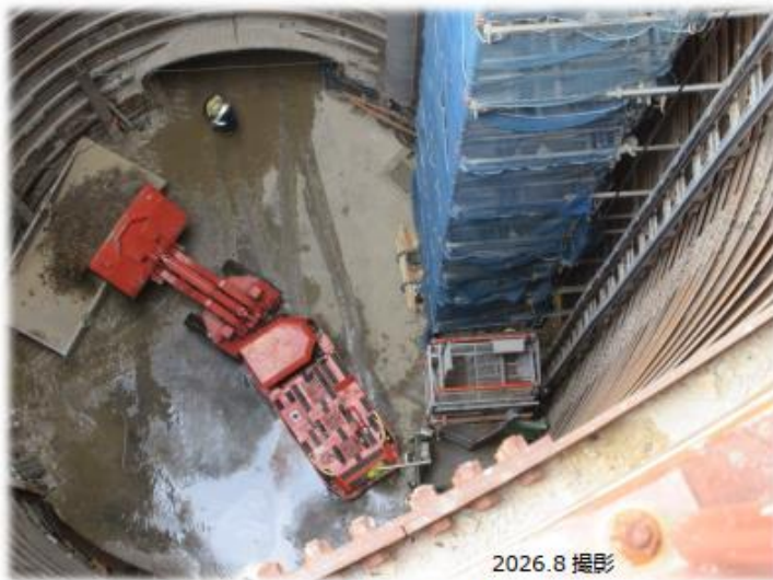
調査坑の掘削 (土砂排出)
