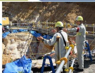
現場の状況を確認する発電所長(右側) 2026.9撮影
