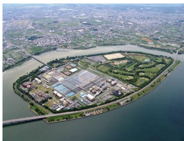
湖南中部浄化センター
