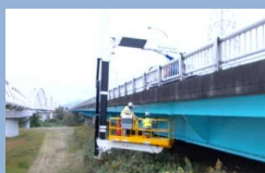
橋梁のメンテナンス
